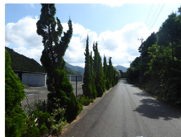
植栽による資材置場の修景
