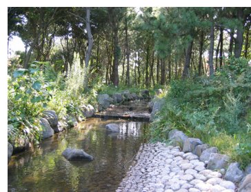
多自然型護岸の例
