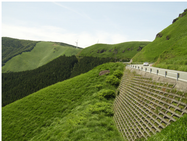
擁壁に緑化を図った例
